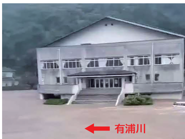
旧有浦小学校体育館前の状況
