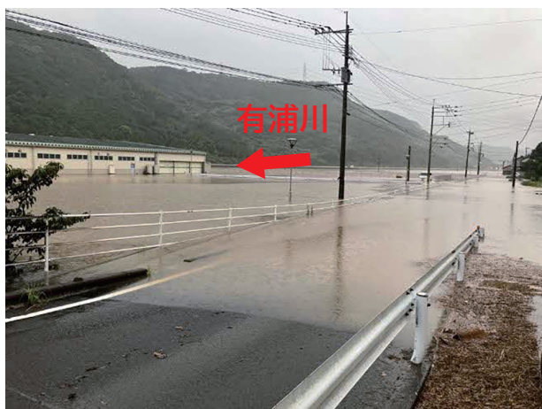
新田付近の状況
