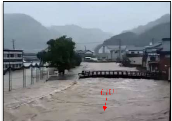
写真6 学校橋の状況
