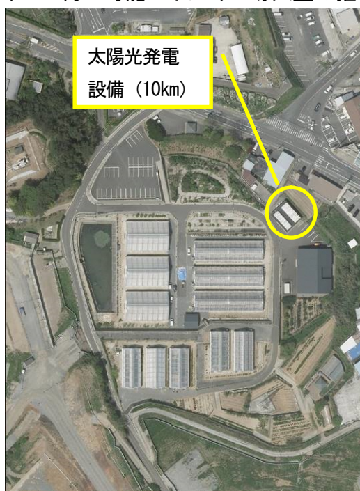
玄海町薬用植物栽培研究所 太陽光発電設備
