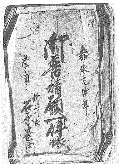
嘉永元年(1848)から書きはじめた有浦新田復旧工事の記録帳
