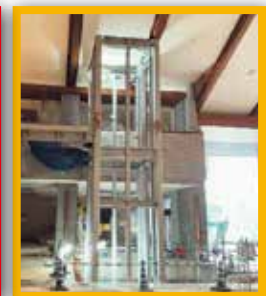
エレベーター設置
