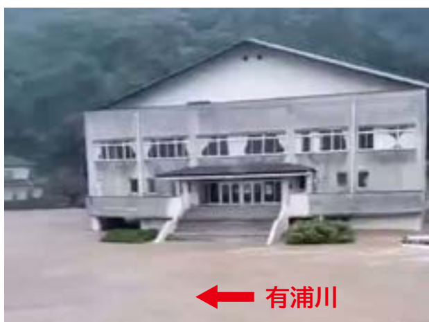
旧有浦小学校体育館前の状況
