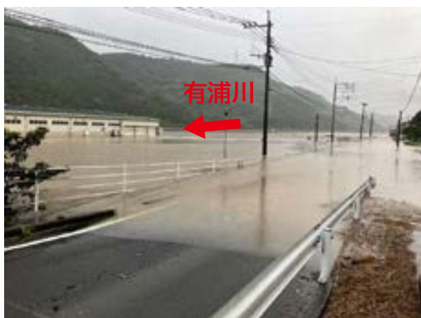
新田付近の状況
