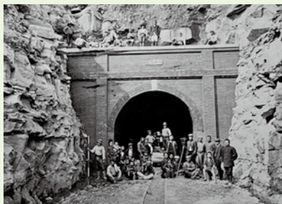
牟形トンネル完成記念写真
