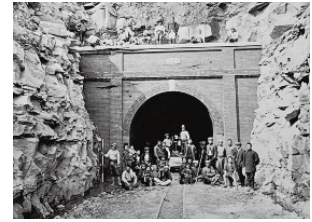
牟形トンネル（大正期）
