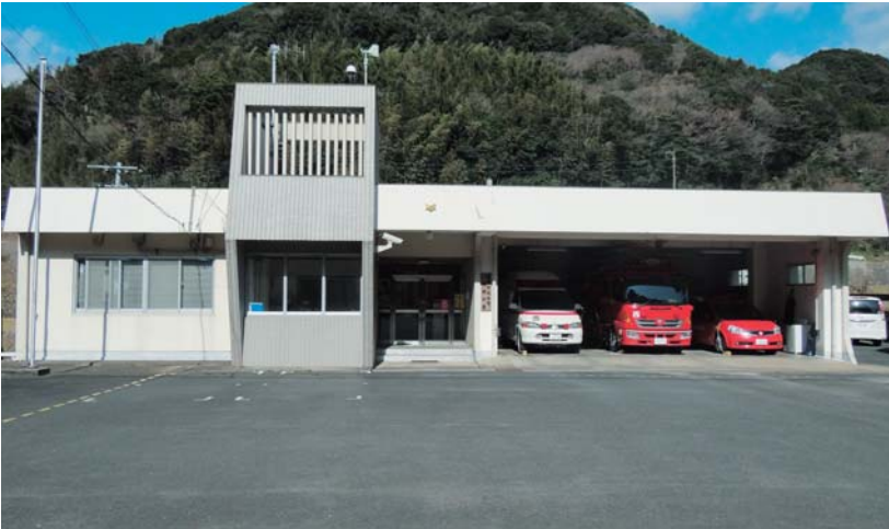
唐津市消防本部消防署西部分署
