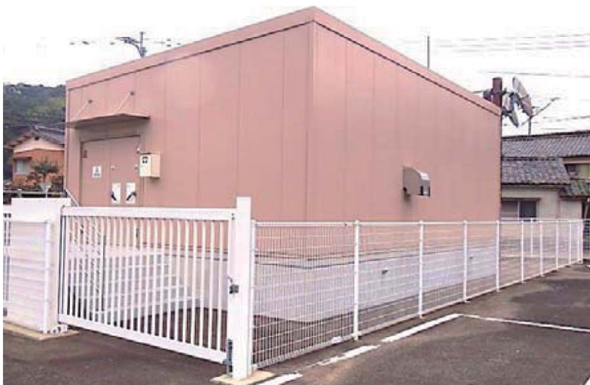
補助対象となった事業者の通信局舎と衛星放送受信アンテナ設備
