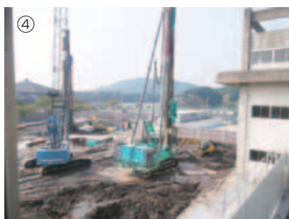
④ 11月14日 約240本の杭を打ち、 校舎を支えます
