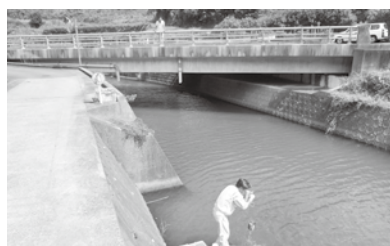
志礼川(一ノ瀬橋付近)
